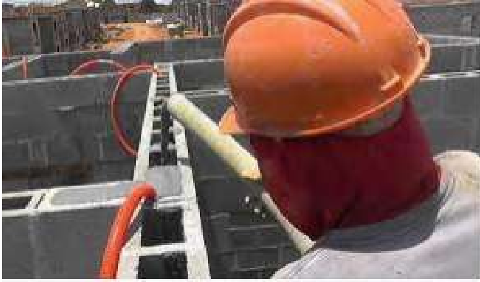
Figura 14 – Aplicação do Graute na Alvenaria Estrutural
