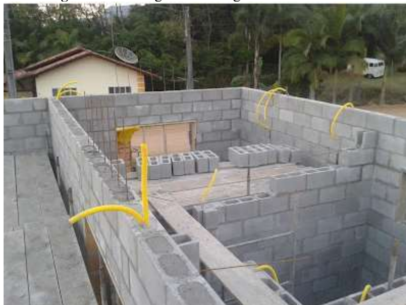
Figura 11 - Passagem das mangueiras - Parte elétrica
