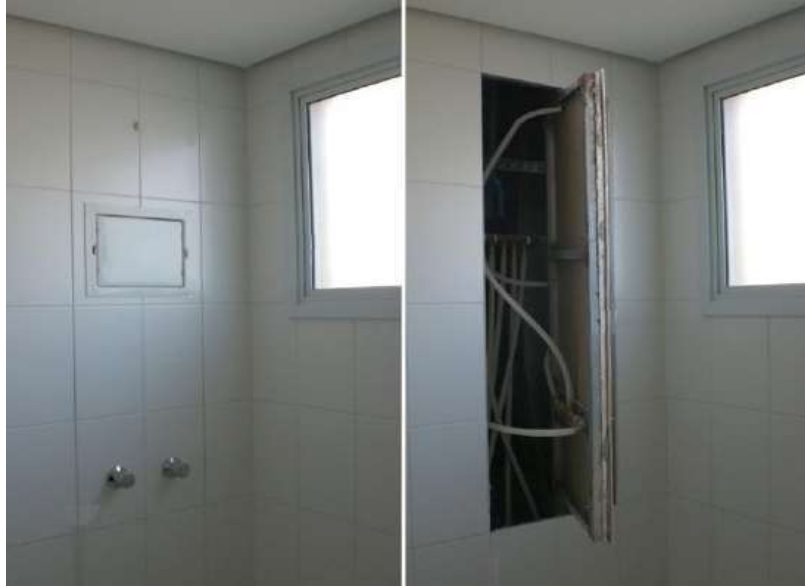
Figura 12 - Utilização de Shaft nas edificações
